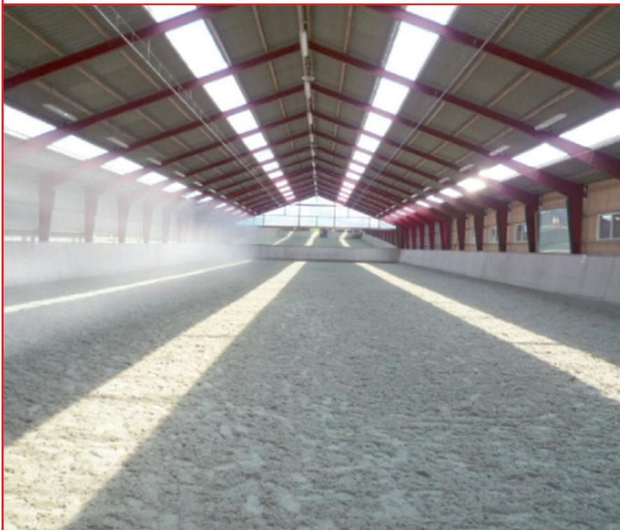
Ce système approuvé se compose de pulvérisateurs fixes sous la toiture du manège sur des filins en acier tendus tous les 90cm. L'arrosage est fin et régulier. La technologie avancée de nos installations favorise une humidité homogène, la poussière dans l'air est capturée, et la durée de vie du sol est prolongée. Meilleur confort pour le cavalier et le cheval.
